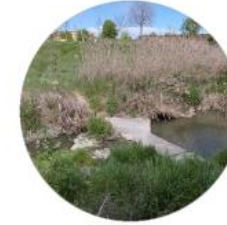
Travessa de formigó actual
