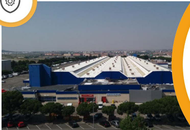
Impermeabilización y revestimiento en blanco de la cubierta de Mercamadrid. Fuente: https://cool-r.es/mercamadrid/
