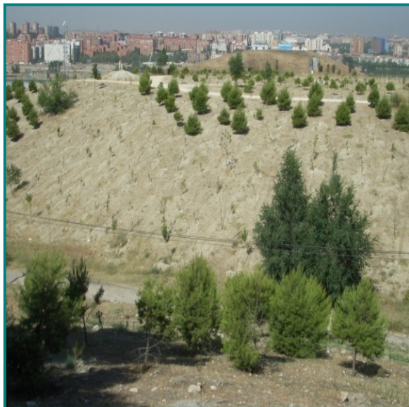
Figura 3.6. Exemple de l'estat de la vegetació en un talussos d'una zona restaurada on es detecta mortaldat de plantes degut a la forta pendent i a la falta de sòl.
