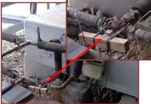
Tram de canonades de distribució a climatitzador sense aïllar. Vàlvula mescladora espatllada.
