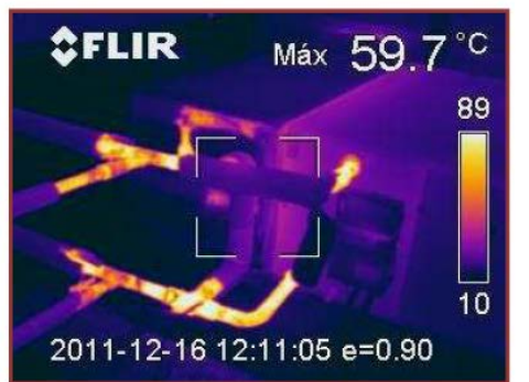
Tram de canonades de distribució a climatitzador sense aïllar. Vàlvula mescladora espatllada.
