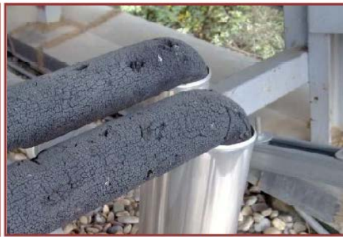
Aïllament incorrecte i degradat tram horitzontal. Aïllament correcte en el tram vertical de canonada.
