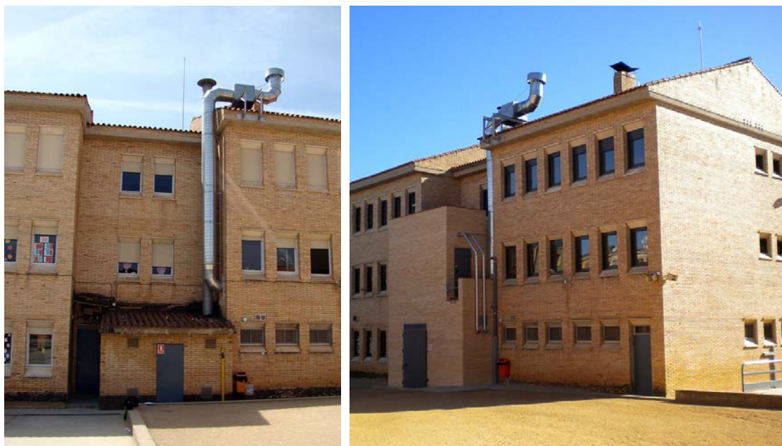
Renovació de la sala de calderes convencional en una escola, potència 220 kW.
