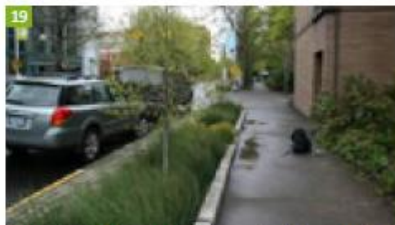
19 Retención y filtrado de aguas pluviales, Portland
