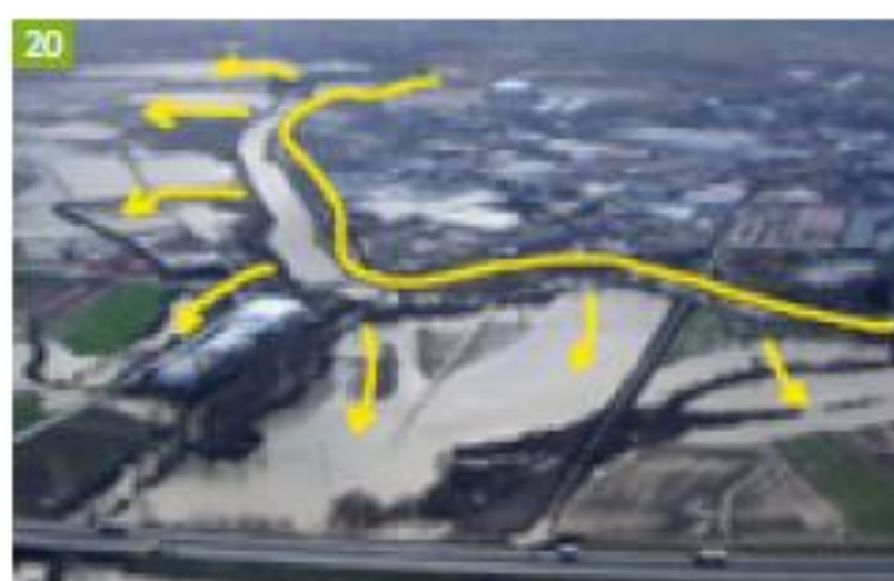
20 Laminación de avenidas del río Zadorra, Vitoria-Gasteiz
