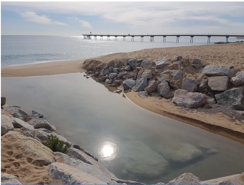
Sobreeixidor del sistema de sanejament metropolità Font: AMB
