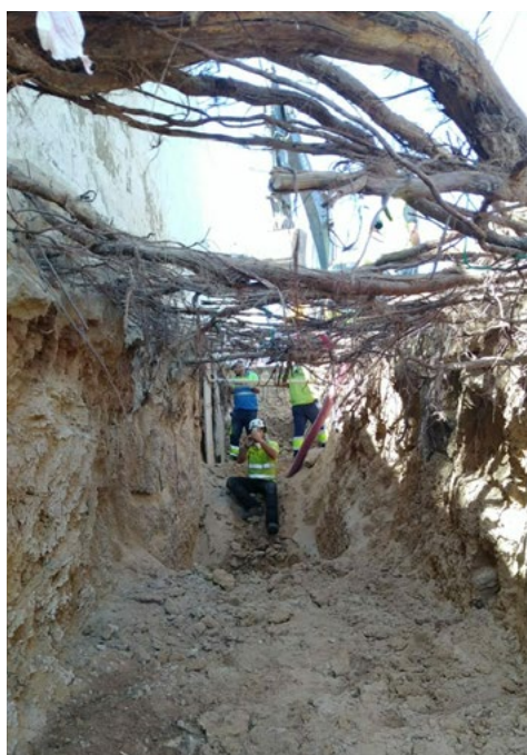
Conservació d'arrels d'un arbre singular amb Airspade® per encabir una línia d'alta tensió soterrada
