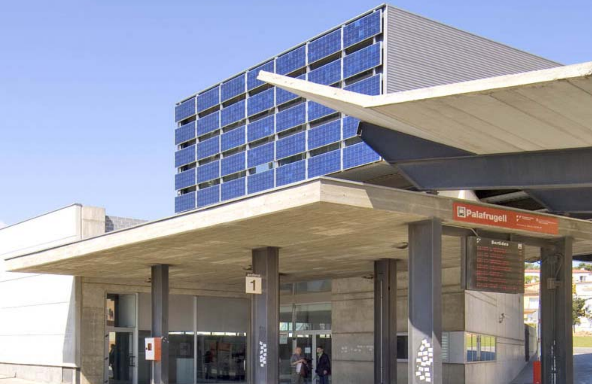
Estació d'autobusos, Palafrugell – 6 kWp
