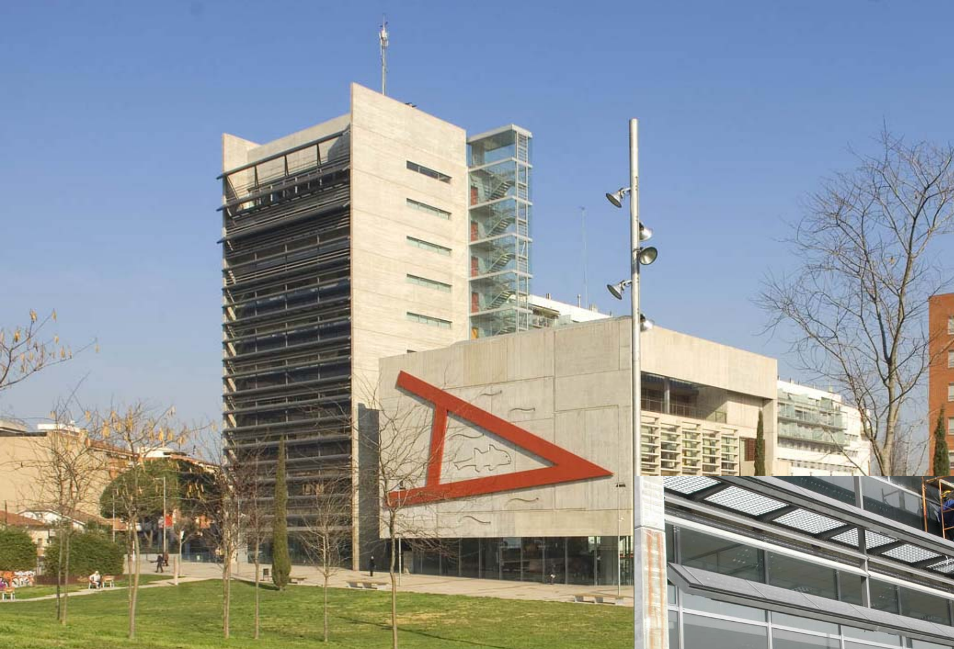
Nova Casa Consistorial de Mollet – 45 kWp
