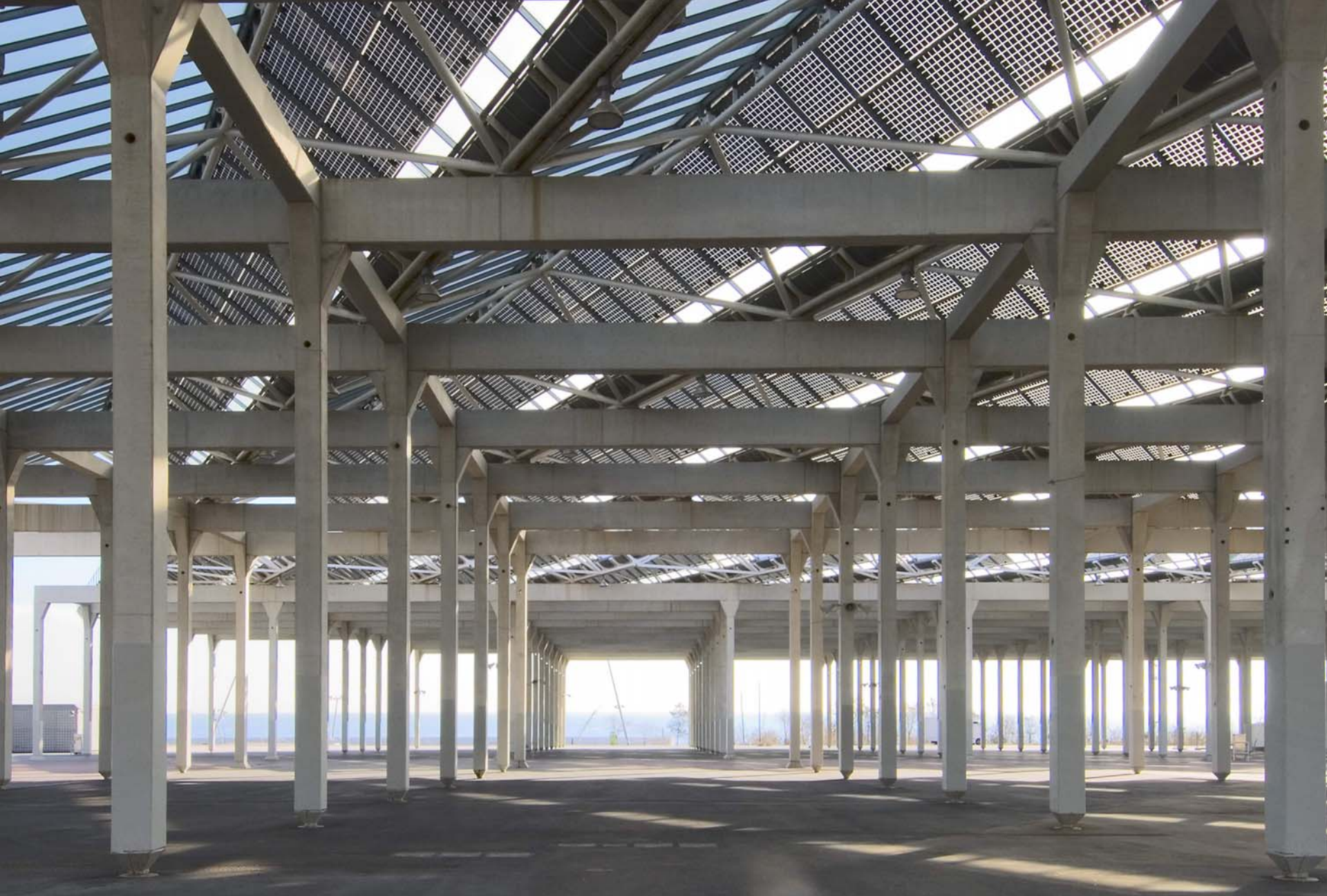
Fòrum, Barcelona – 660 kWp
