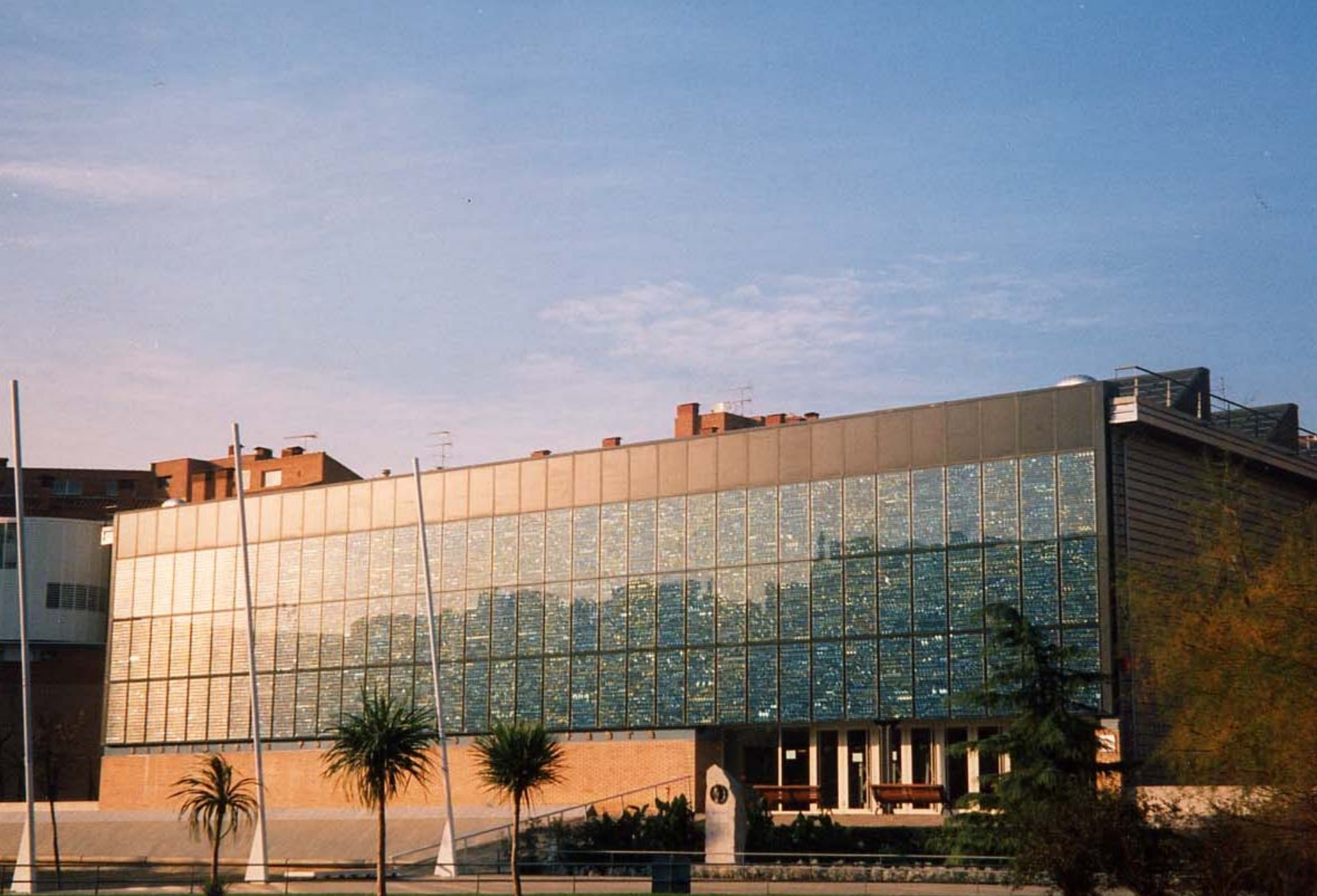
Biblioteca Pompeu Fabra, Mataró – 50 kWp
